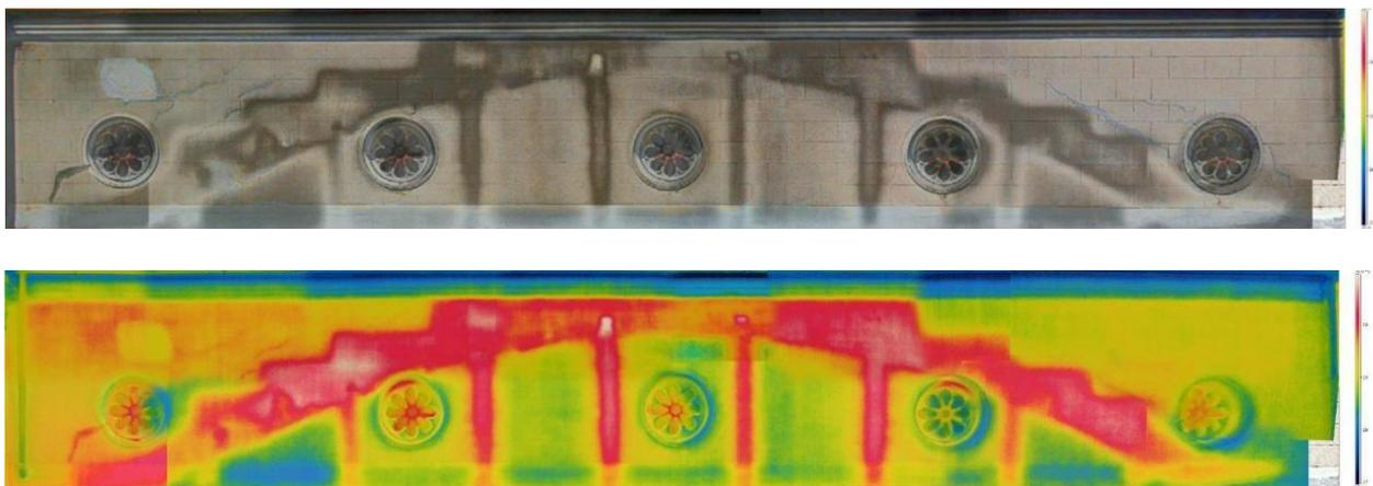
Figura: Esempio di ripresa termografica della struttura in cemento armato della Chiesa di Santa Maria Addolorata, Pratozanino, Cogoletto.
